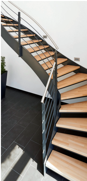
Flachstahlwangentreppen
