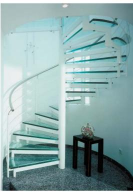
Die Kanten des in drei Schichten laminierten Glases können nicht mehr nachgeschliffen werden. Darum liefert Fuchs die Konstruktionsdaten für die automatisierte Fertigung direkt an den Hersteller.
